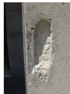
Figura 3.37: Degradação do ETICS, por suscetibilidade aos choques [Malanho & Veiga, 2012]
