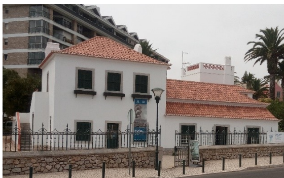
Figura 4.34: Aspeto exterior do Edifício K após reabilitação
