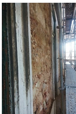
Figura 4.27: Fachada existente do edifício H em alvenaria de pedra e tijolo
