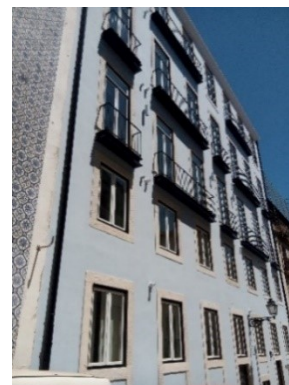
Figura 4.33: Fachada de tardoz do edifício J após reabilitação
