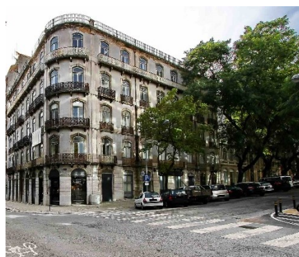
Figura 4.28: Aspeto exterior do edifício H antes da intervenção [imagem retirada do Google Maps]
