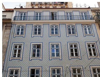
Figura 2.17: Revestimento em azulejo (Edifício do Elevador do Castelo na Baixa) [w3]
