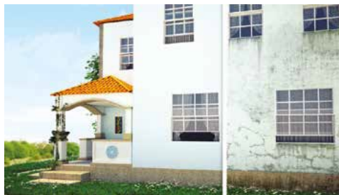
Figura 3.36: Renovação estética de fachadas com anomalias existentes, através da aplicação de ETICS [APFAC, 2015]
