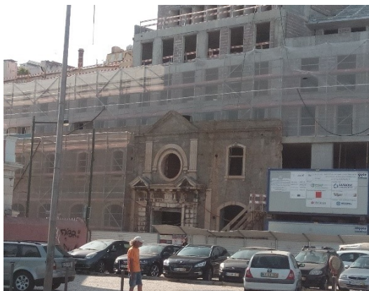
Figura 4.20: Fachada principal do edifício F, com estruturas existente e acrescentada
