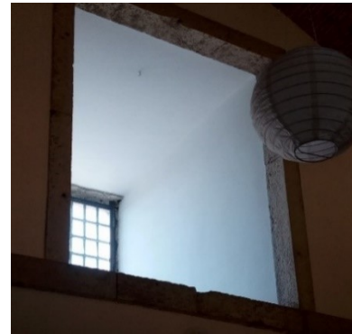
Figura 4.39: Fachada do piso térreo com espessura de aproximadamente 1 m
