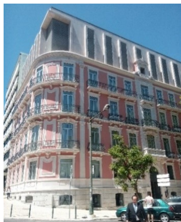
Figura 4.25: Aspeto exterior do Edifício G após reabilitação
