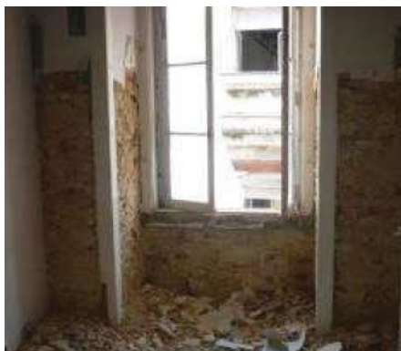
Figura 4.31: Fachada do edifício J em alvenaria de pedra, durante a intervenção [arquivo de obra]
