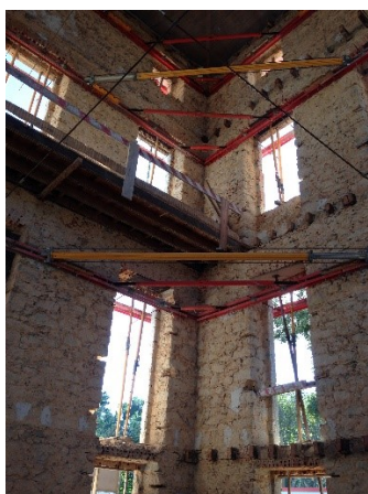
Figura 4.6: Contenção das fachadas existentes do edifício B [arquivo de obra]
