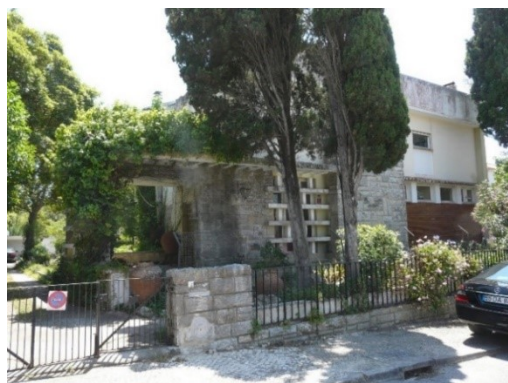
Figura 4.17: Fachada principal do edifício E [arquivo de obra]
