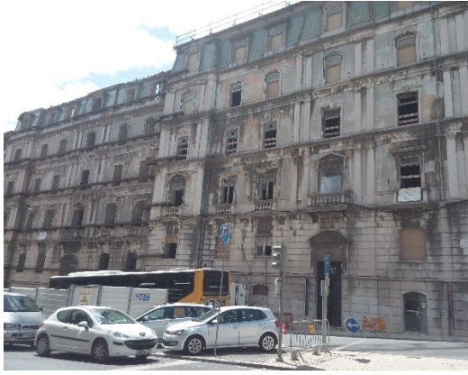
Figura 4.2: Fachada dos edifícios A durante a fase de obra de reabilitação
