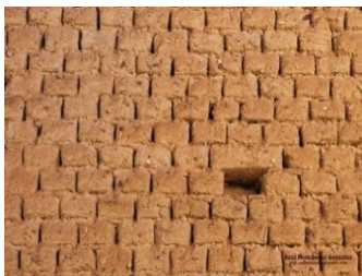
Figura 2.4: Paredes de taipa ou adobe [w2]
