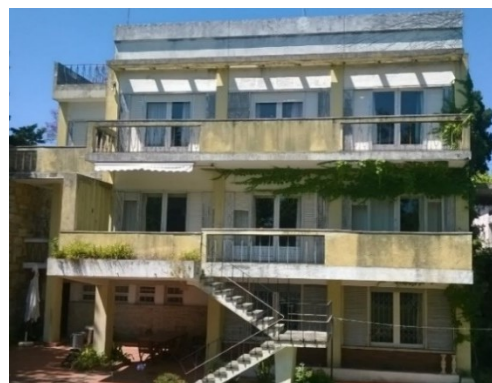
Figura 4.18: Fachada de tardoz do edifício E [arquivo de obra]
