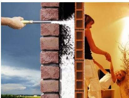
Figura 3.22: Injeção de lã mineral (MW) na caixa-de-ar para reforço térmico de paredes duplas [Knauf Insulation, 2012]
