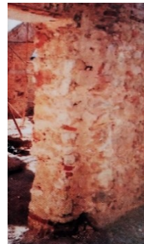
Figura 2.8: Alvenaria de pedra ordinária [Pinho, 2008]
