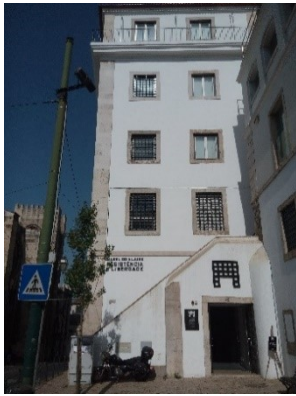
Figura 4.37: Fachada do edifício L após reabilitação
