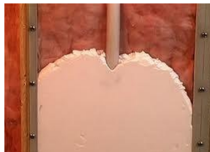
Figura 3.23: Injeção de espuma rígida de poliuretano (PUR); para reforço térmico de paredes duplas [w8]
