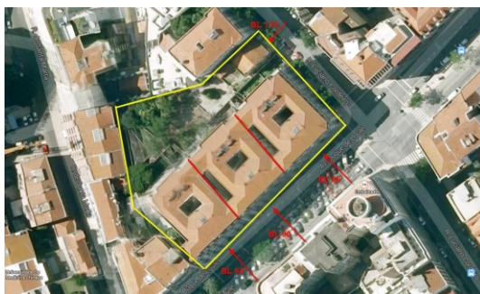
Figura 4.1: Delimitação do conjunto urbano reabilitado do caso de estudo A [arquivo de obra]
