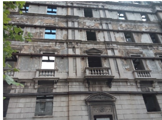
Figura 4.5: Pormenor do paramento exterior da fachada dos edifícios A
