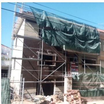
Figura 4.15: Fachada do edifício D em fase de aplicação de isolamento térmico
