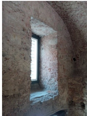
Figura 4.38: Parede exterior mista de alvenaria de pedra e tijolo
