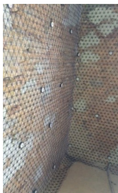
Figura 4.9: Reforço da fachada existente com rede metálica [arquivo de obra]
