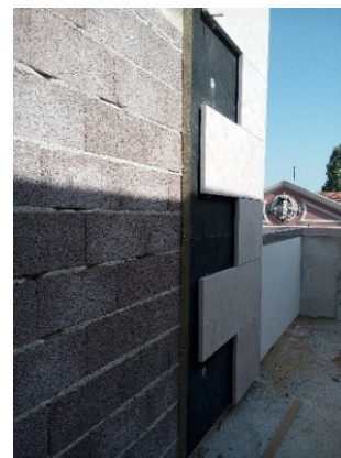
Figura 4.21: Parede nova exterior com blocos de argila expandida e fachada ventilada
