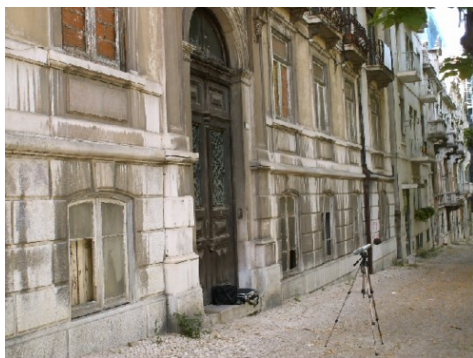
Figura 4.24: Aspeto exterior do Edifício G antes da intervenção de reabilitação [arquivo de obra]
